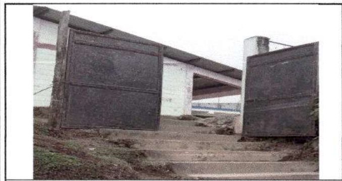
Foto 5: Sustrucción de puerta.
