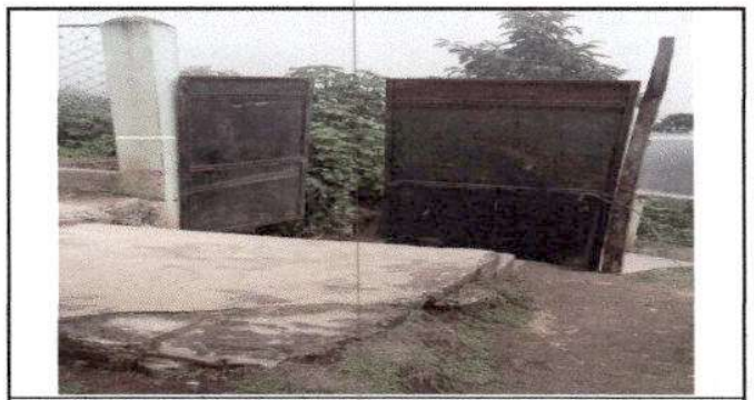
Foto 6: Sustrucción de puerta.
