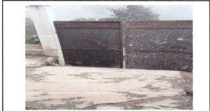
Foto 1: Sustrucción de puerta.
