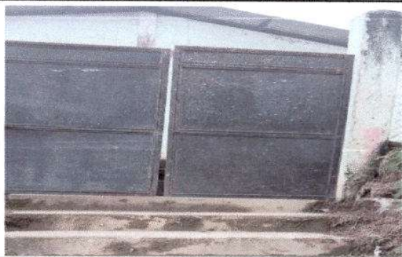
Foto 3: Sustrucción de puerta.
