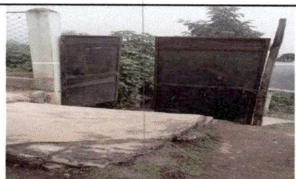
Foto 6: Sustrucción de puerta.
