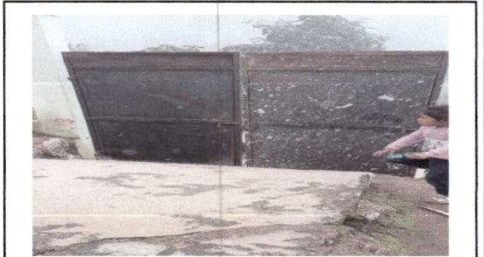
Foto 2: Sustrucción de puerta.
