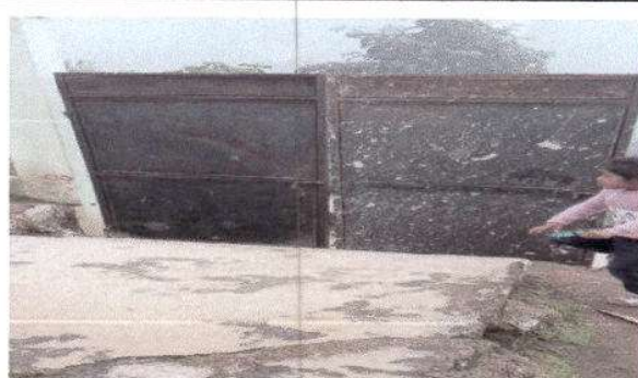
Foto 2: Sustrucción de puerta.
