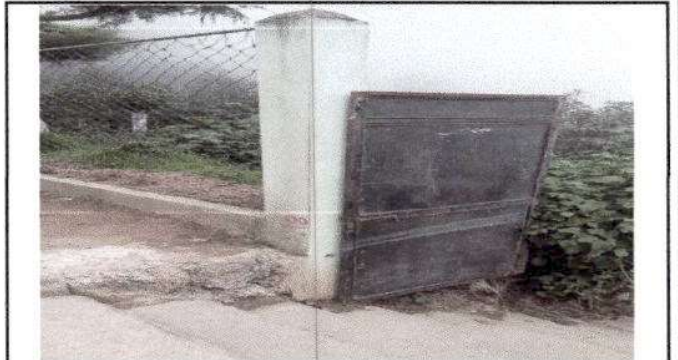
Foto 4: Sustrucción de puerta.
