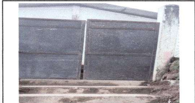
Foto 3: Sustrucción de puerta.
